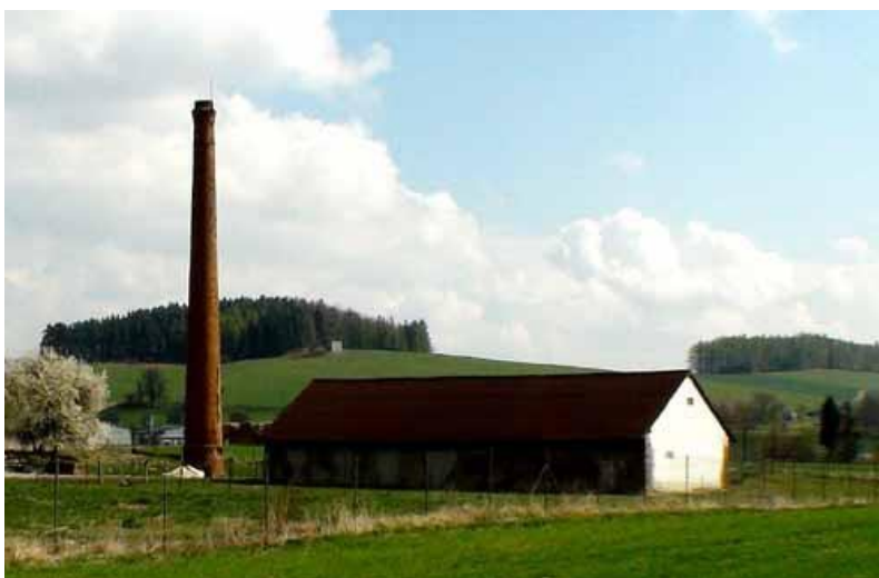
Obrázek 149 zachovaný komín po bývalé cihelně
