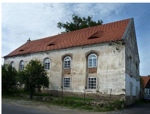
Obrázek 47 Synagoga před rekonstrukcí
