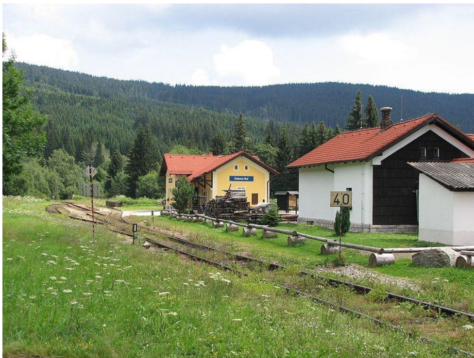
Obrázek 72 Železniční stanice Kubova Huť
